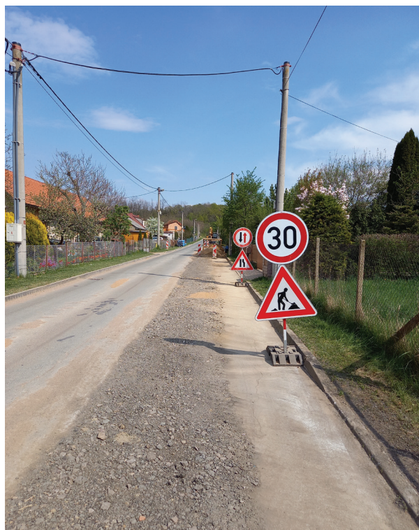
Kanalizace Homyle, Foto Vítězslav Havlíček
